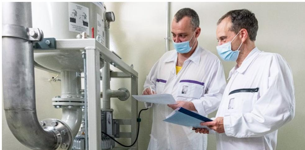
**Dans l'enceinte de confinement: mise en service d'un ventilateur à vapeur d'huile pour la régulation de la dépression dans le système d'huile de lubrification d'une pompe de refroidissement principale. Image: centrale nucléaire de Gösgen**
